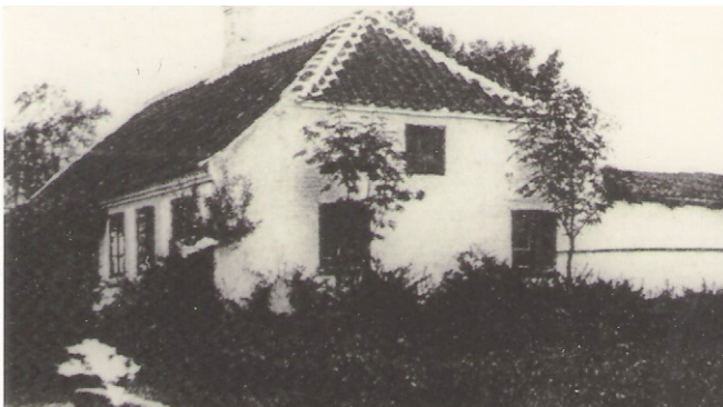
Udsnit fra et postkort visende Freltofte Brugs' udseende i begyndelsen af 1900-tallet. Det er på nuværende det ældst kendte billede af brugsen, og den ene af de to i brevet nævnte brandmurer er synlig. Taget teglhængt, endnu med valmede gavle, rygningstenene forskellet med kalkmørtel.
