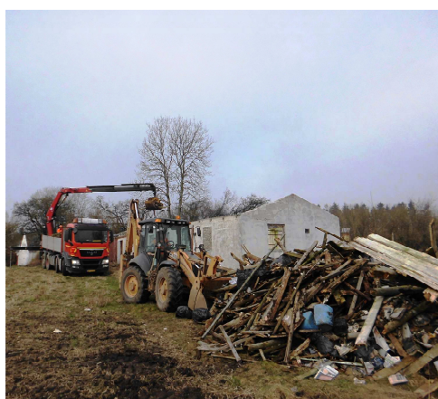
Nedbrydning af ruin på Birkebjergvej
