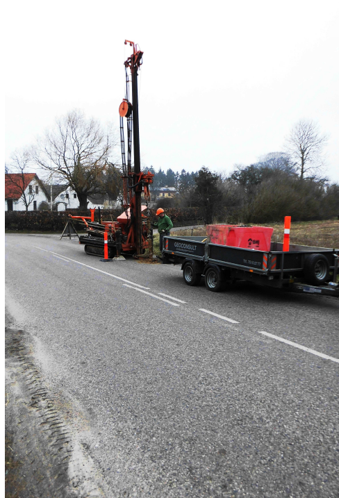
Boreriggen i arbejde på Freltoftevej
