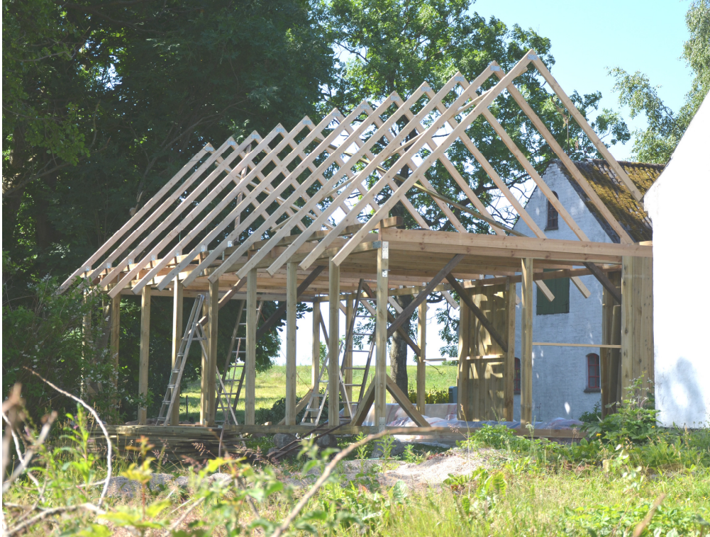
Vognportens skelet, der er bygget som en moderne bindingsværkskonstruktion med fod- og tagrem, stolper og skråbånd.
